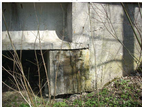
Průsaky úložným prahem na boční plochu OP1 vlevo
