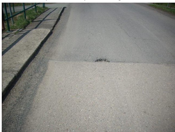
Počínající výtluk u mostního závěru na konci mostu
