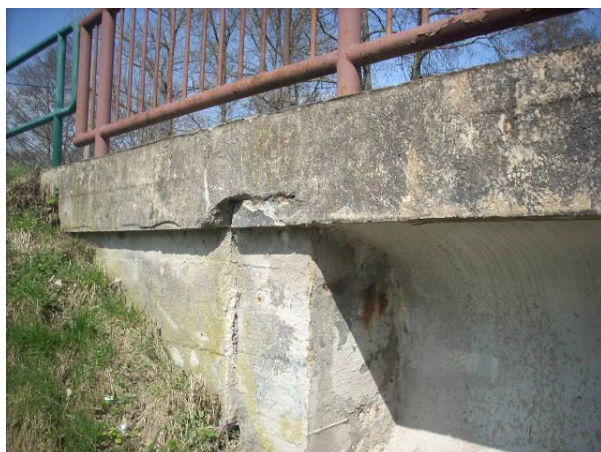
Poškození hrany římsy v místě dilatace na konci vpravo
