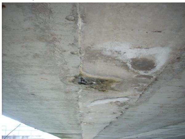
Uvolněné výplně dobetonávek nosníků s výluhy
