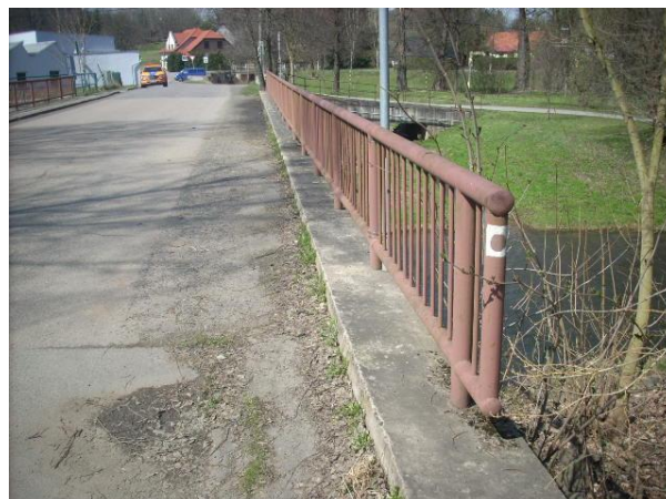
Znečištěné krajnice vozovky po zimním období
