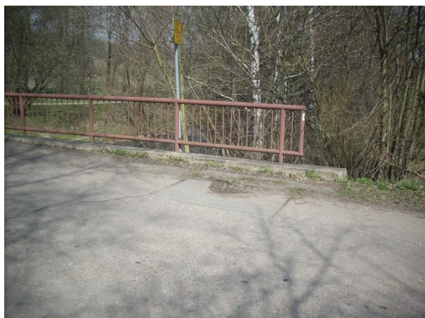
Výsrava vozovky na začátku mostu vpravo
