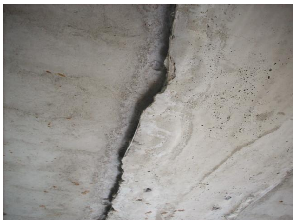
Podhled NK, separace dobetonávek na spodním líci
