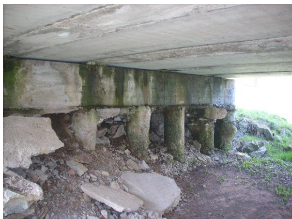
Obnažené piloty OP2, vpravo
