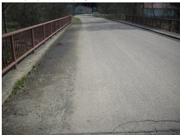
Nečistoty na krajnicích, kaluže srážkové vody vpravo
