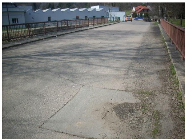
Poruchy krytu vozovky, vpravo
