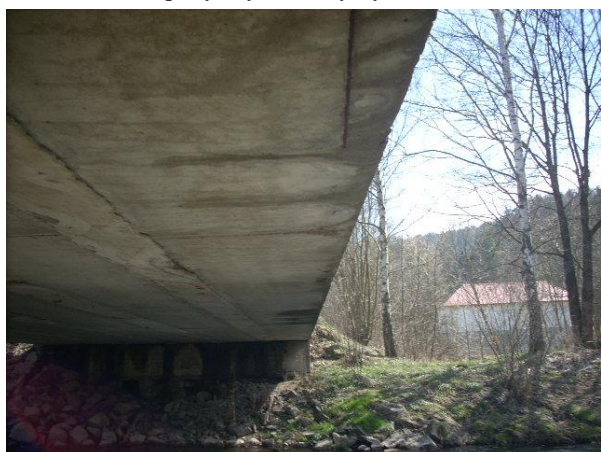
Vápenné výluhy na podhledu krajního nosníku, vlevo
