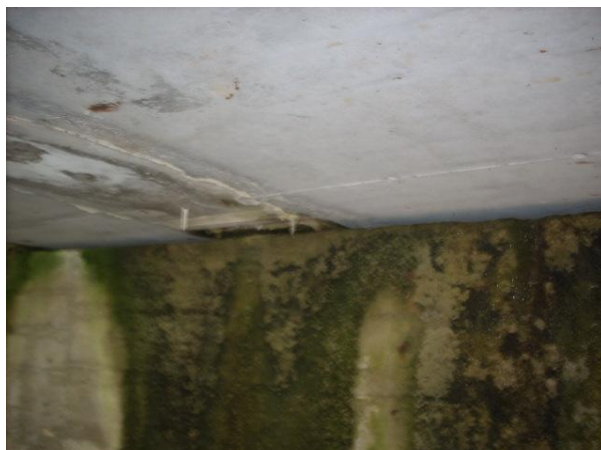
OP1, četné průsaky přes úložný práh
