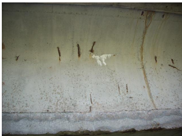
Prorýsovaná koroze trmínků krajních prefabrikátů
