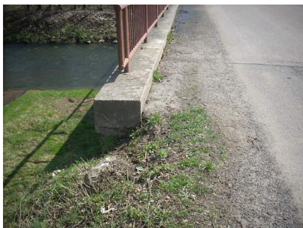
Uvolněný svahový kužel na konci mostu vpravo
