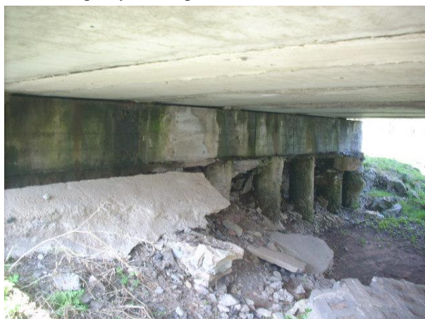
Uvolněné svahové tvárnice na opevnění před OP2
