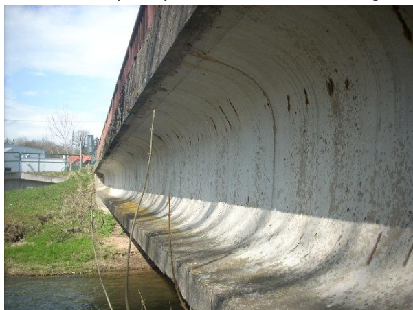
Plošné znečištění krajních nosníků a říms výkvětem
