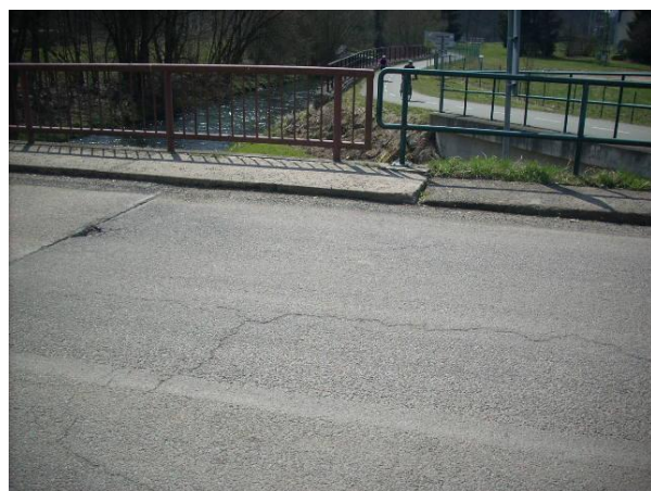
Trhliny a výškové deformace vozovky na předpolích
