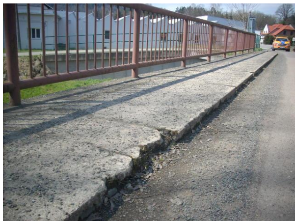
Olámané hrany do vozovky u lícních prefabrikátů
