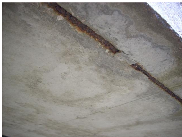
Koroze výztuže hlavních nosníků
