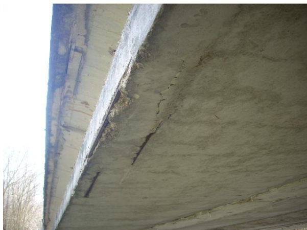
Podhled NK, opady krycí vrstvy výztuže
