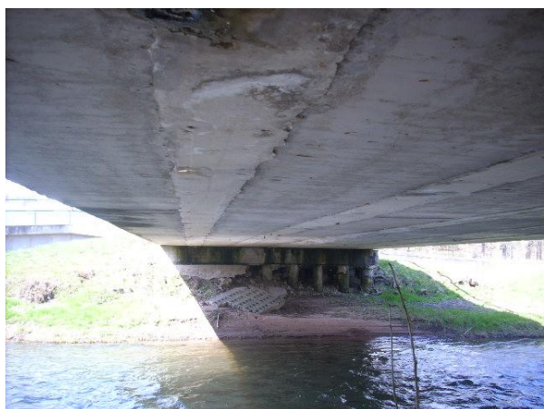
Podhled NK, dobetonávky mezi hlavními nosníky
